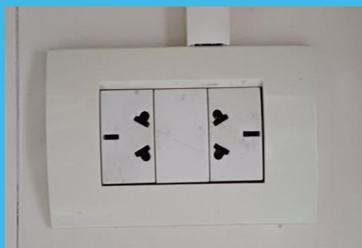
Tomacorrientes compatibles con espigas cilíndricas
